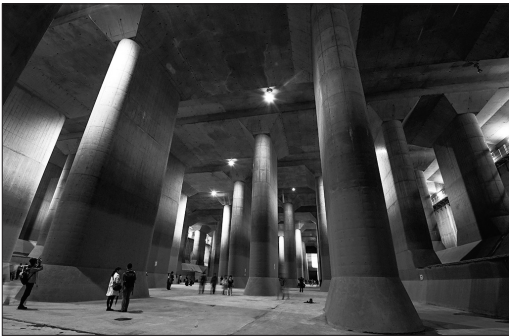
資料Ⅳ 首都圏外郭放水路
